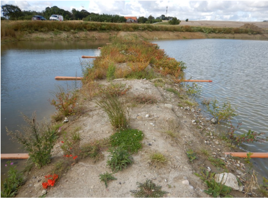
Figur 7.3 - Bræmme med rørføring. Vandet har endnu ikke nået udløbskoten, hvorfor rørene ikke er helt neddykkede.
