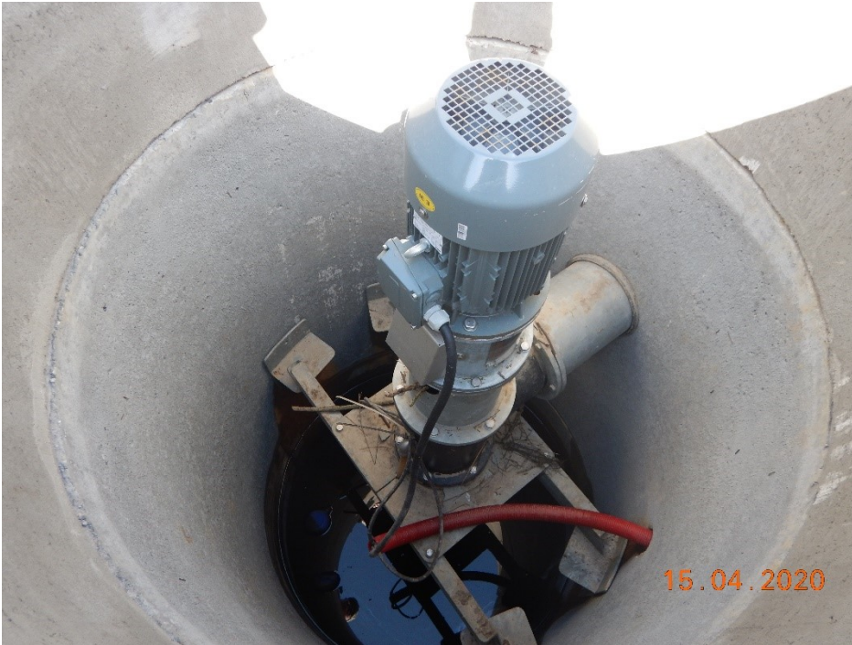
Figur 4.5 Vandet kan også pumpes ind i minivådområdet. Bemærk at der ikke ydes pumpetilskud hvis drænoilandet er under 50 ha.
