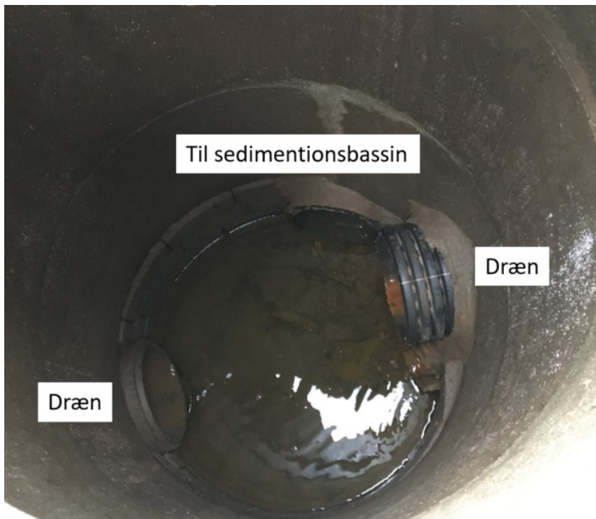
Figur 4.2 Drænrørene samles i en samlebrønd inden sedimentationsbassin
