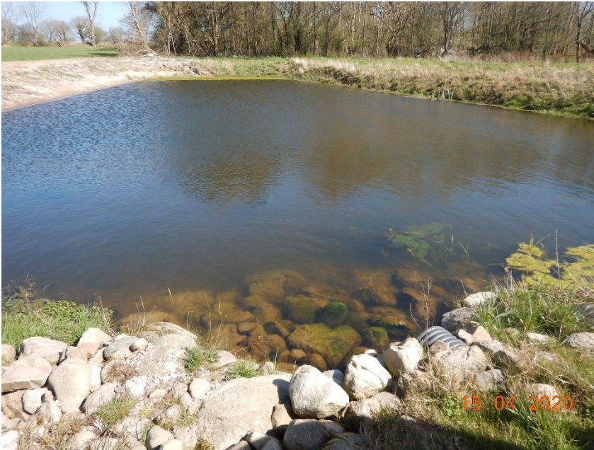
Figur 4.6 Sedimentationsbassinet opsamlers sediment og bundfælder fosfor.
