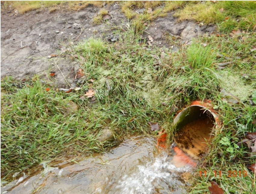
Figur 5.3 Drænrøret forsyner minivådområdet med vand.
