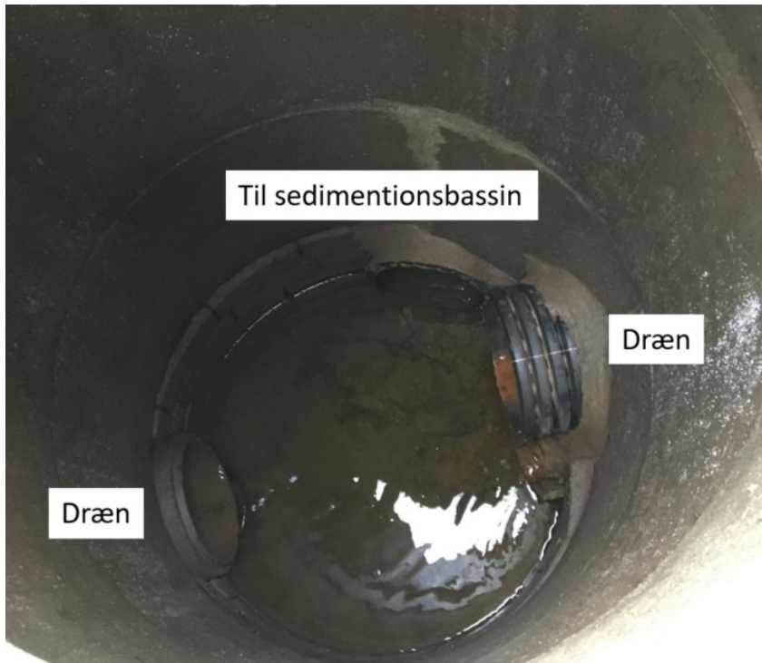
Figur 5.2 Drænrørene samles i en samlebrønd inden sedimentationsbassinet
