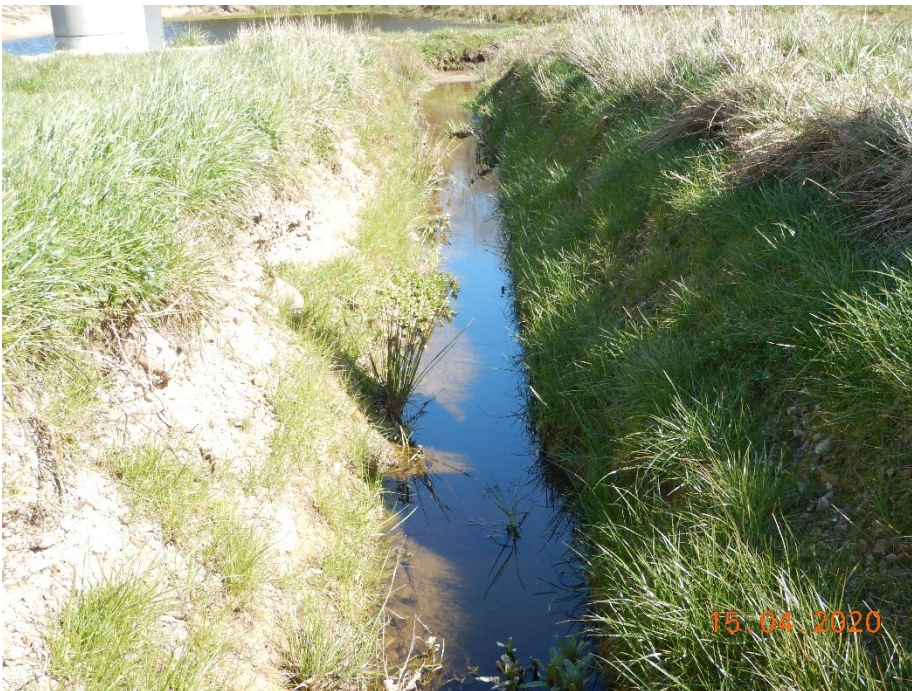
Figur 5.4 Grøft med vand.
