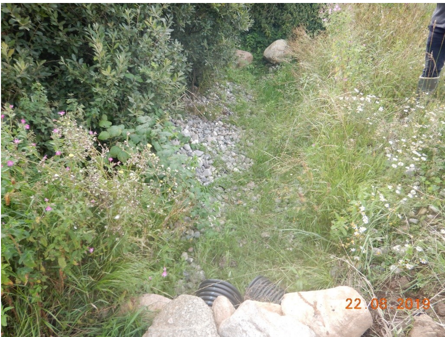
Figur 5.12 Iltningstrapper. Iltningstrapper kan se forskellige ud, som de to eksempler her viser. Vandet skal iltes før det ledes ud i vandsystemet (recipienten).
