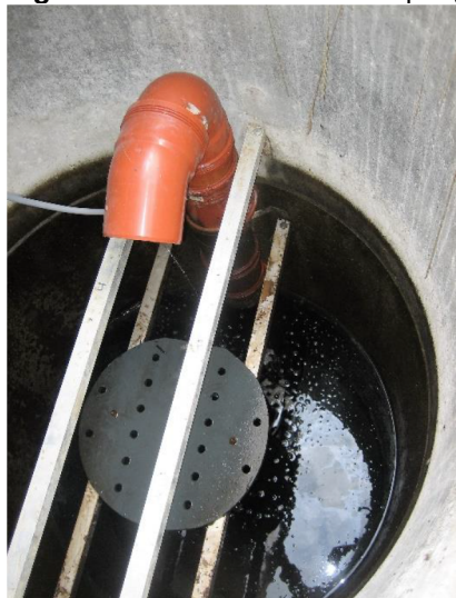
Figur 13.3 Fotoet viser en simpel genilttingsbrønd med en hullet plade, der medvirker ved geniltning.
