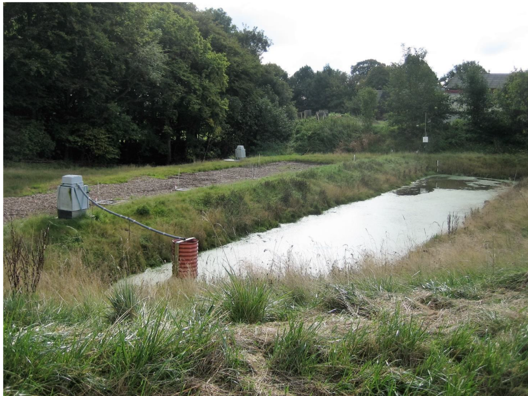
Figur 7. Foto af matriceminivådområde med stuvningsbassin. Forrest i billedet ses det store vertikalt stillede perforerede rør, der passivt styrer vandstanden i stuvningsbassinet.
