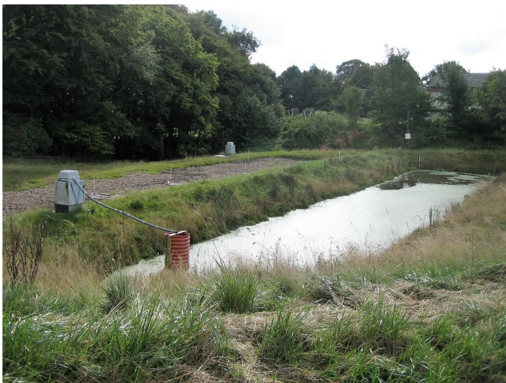
Figur 13.2 Foto af minivådområde med filtermatrice med stuvningsbassin. Forrest i billedet ses det store vertikalt stillede perforerede rør, der passivt styrer vandstanden i stuvningsbassinet.
