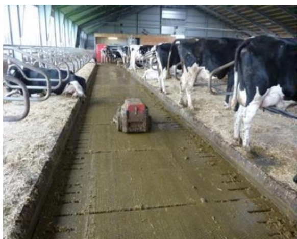
Figur 2.1: Præfabrikeret drænet fast gulv med tværgående spalter til løbende aflevering af gødning under skrabning samt kontinuerlig dræning af ajle mellem skrabninger. Gulvet ligger på en ringkanal eller kanal med linespil.
