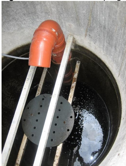
Figur 8. Fotoet viser en simpel genilttningsbrønd med en hullet plade, der medvirker ved geniltning.
