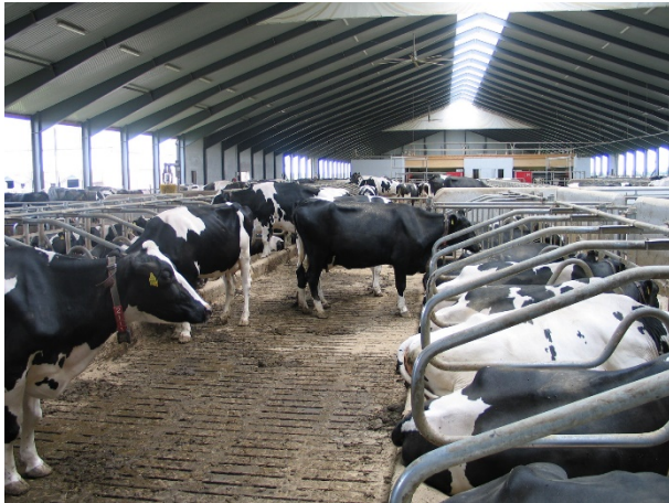
Figur 1. Foto af sengebåsestald med spaltegulv i gangarealerne. Under spaltegulvet er der en gyllekanal opbygget med enten ringkanalsystem eller med bagskyl. Sengebåsene er støbt i beton og er hævet i forhold til spaltegulvet og er udstyret med bøjler for adskillelse af køerne, når de ligger. Bunden af sengebåsene dækkes med enten gummi-måtter, strøelse eller lignende.
