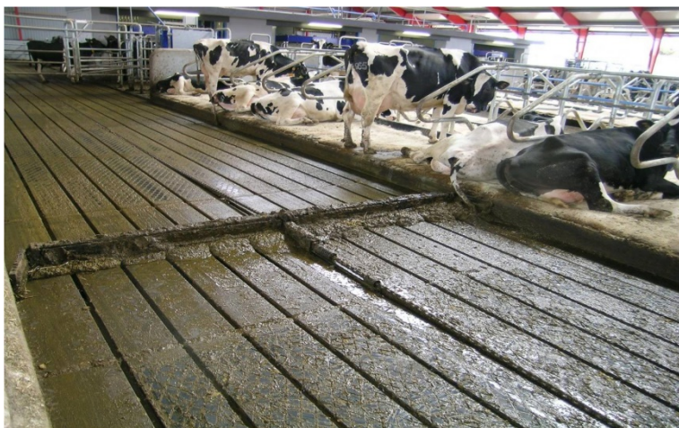
Figur 2. Eksempel på sengebåsestald med fast drænet gulv med skraber og ajlefløb (vist med Perstrup præfabrikeret gulv).
